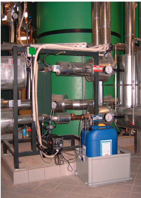
Dávkovanie látky DOUZON 100 L pomocou kontaktného vodomera.
