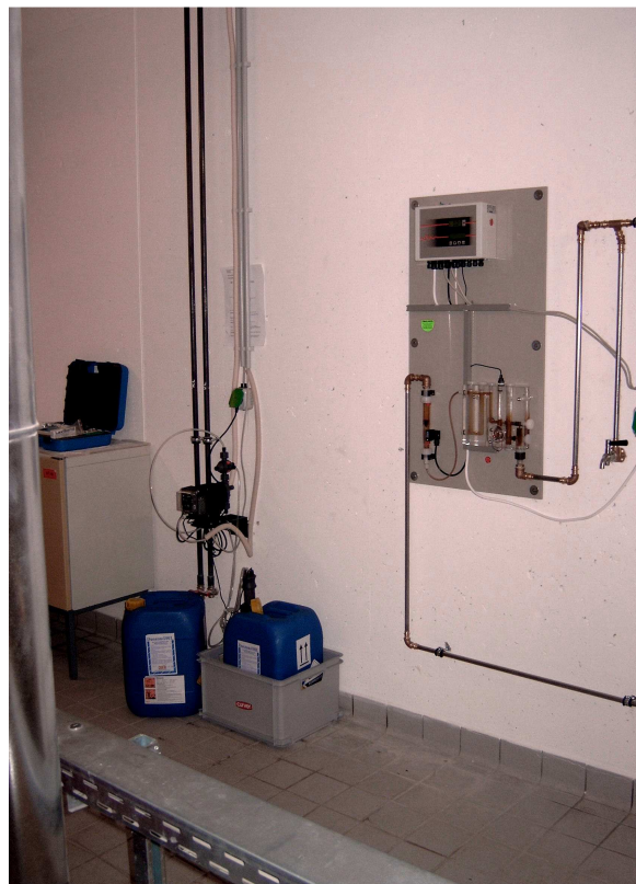
Dávkovanie látky DUOZON 100 L pomocou plne automatizovanej meracej a regulačnej sústavy
